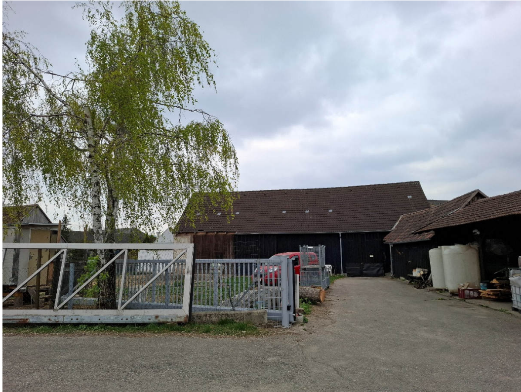
Abbildung 7: Fotoaufnahmen des ggst. Bereichs
